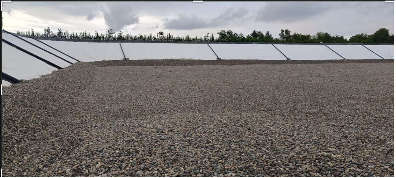
FIGURA 3: STATO DEI LAVORI A GIUGNO 2024
